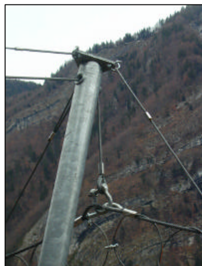
Détail tête de poteau écran parepierres CAN D 1500 KJ
